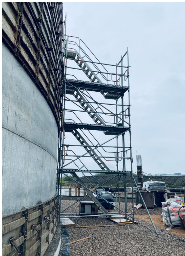
4.16. attēls. Izliekti tērauda veidņi ar metāla virsmu
