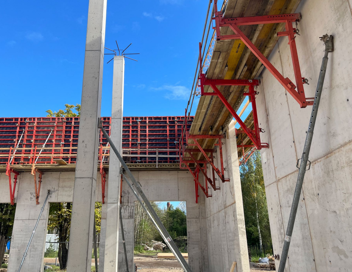
4.11. attēls. Rāmjeida veidņu piemērs. Doka. Kaigan Villas
