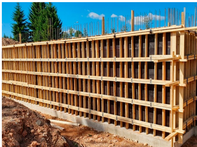
4.19. attēls. Betona virsmas piemērs, kas iestrādāta ar koka veidņiem, kas uzbūvēti uz vietas
