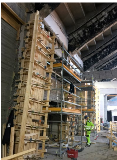
4.18. attēls. Uz vietas būvēts koka veidnis
