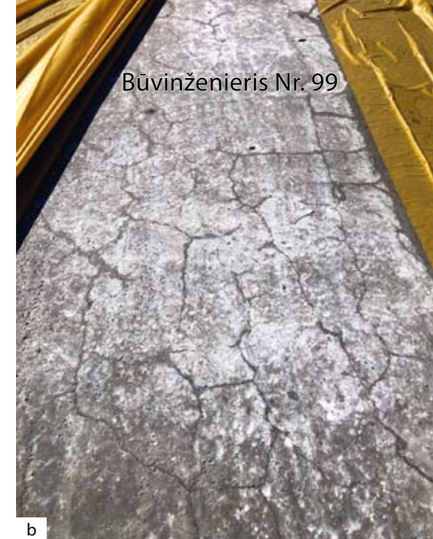
1. attēls. (a) plastiskā rukuma plaisas, kas radušās, mitriem dubļiem izžūstot saulē; (b) plastiskā rukuma plaisas sacietējušā betonā (plaisas radās vēl pirms betona saistīšanās, t. i., kamēr betons vēl bija svaigs).
